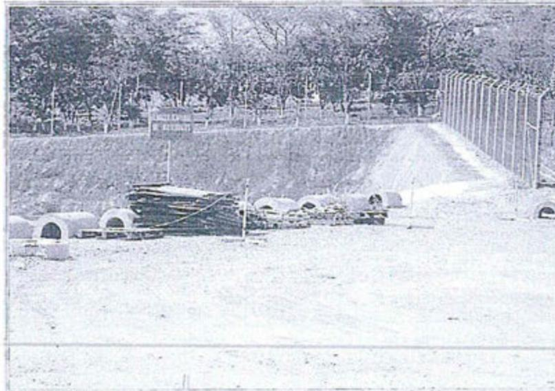
Fotografía N° 5: Almacenamiento de residuos sólidos industriales sobre terreno natural en las estaciones de válvulas, recomendación N° 3.
