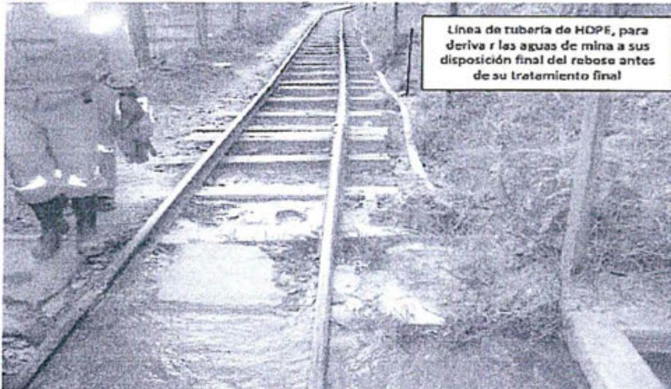
Fotografía N° 19.- Canal de derivación de aguas de mina de la bocamina Estrella (NV-1467), en el cruce de la vía férrea hacia las pozas de sedimentación se produce un rebose de las aguas al ambiente antes de su tratamiento final de sedimentación.
