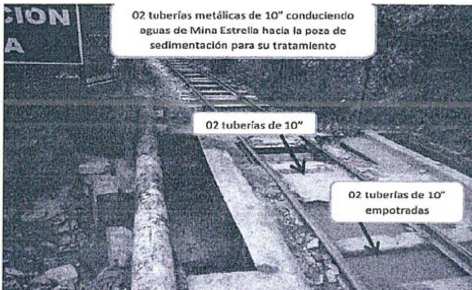
Foto N° 26: 2 tubos de 10" colocados para captar el efluente proveniente de la Bocamina Estrella y llevarlo hacia la poza de sedimentación, evitando el rebose del efluente.
