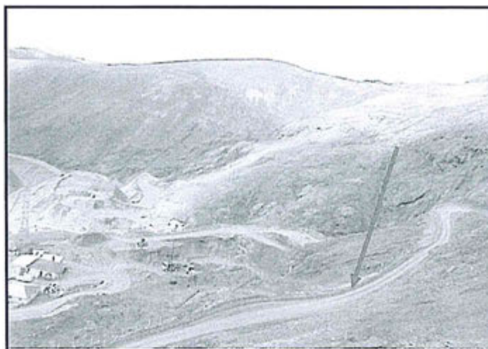
Canal de coronación del acceso que deriva el agua de escorrentía
