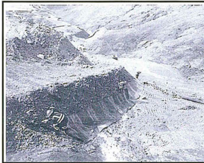
Instalación de geomembrana en canal
