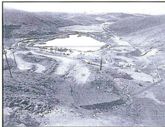
Vista panorámica del canal
