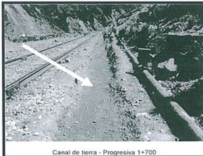
Canal de tierra - Progresiva 1+700
