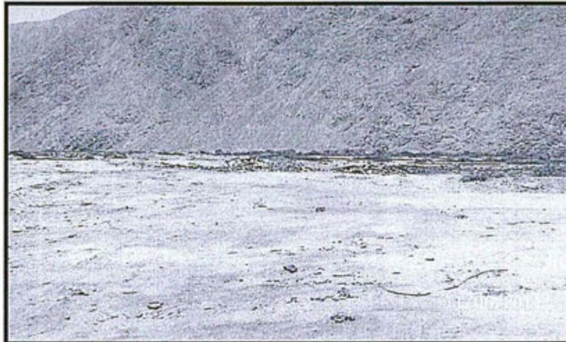
Fotografía N° 37: Área de disposición final de residuos sólidos domésticos no cuenta con cobertura, barreras sanitarias ni impermeabilización.
