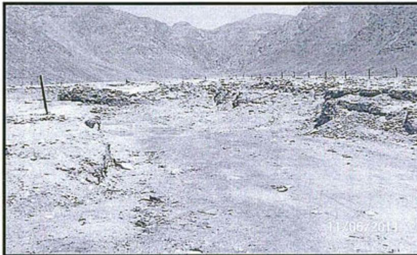
Fotografía N° 38: Área de disposición final de residuos sólidos domésticos no cuenta con cobertura, barreras sanitarias ni impermeabilización.
