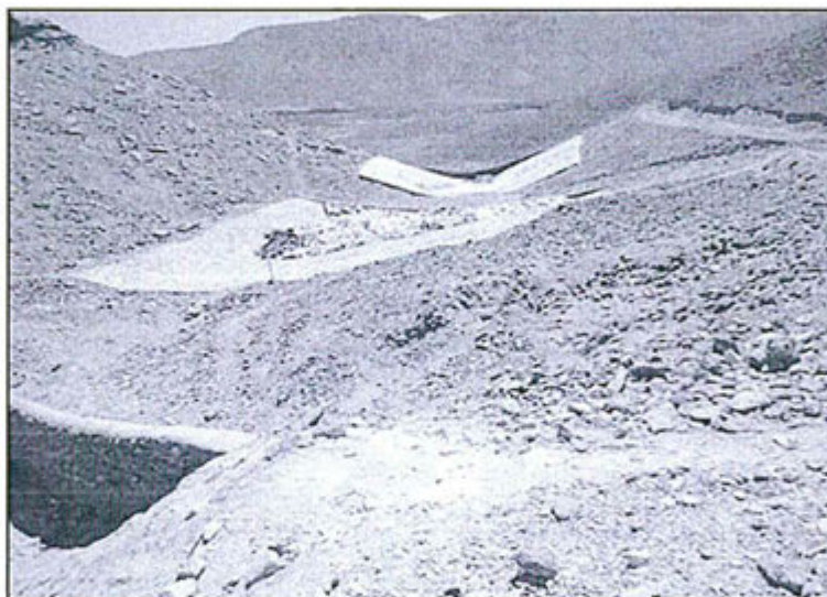
Fotografía N° 6: Relleno sanitario, falta letreros de identificación y chimeneas y/o tubos de ventilación.
