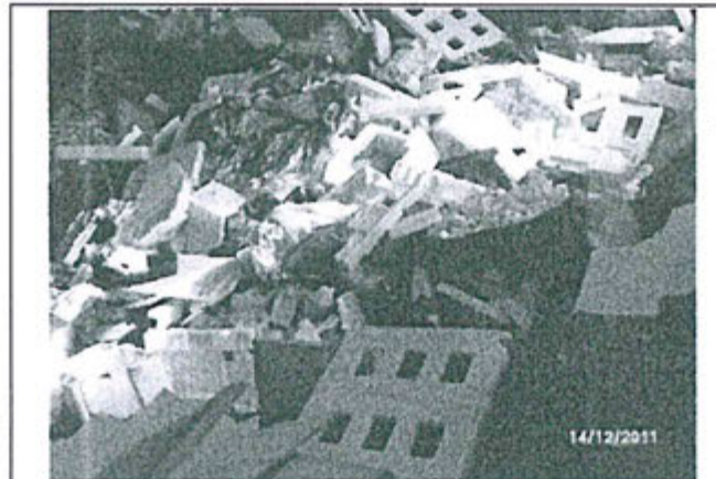
Foto N° 9. Lote X - Almacén Rezago Laguna.- Existe gran cantidad de residuos industriales no peligrosos (tecnopor y otros materiales) sin segregar, dispuestos en bolsas y "a granel" sobre el piso del Almacén.
