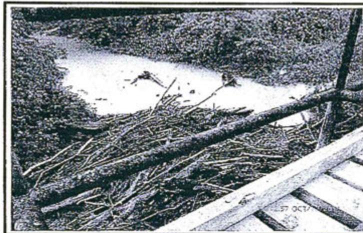
**Fotografía N° 1:** Muestra abundante troncos, palos y maleza, ejerciendo presión sobre la base del puente de Mashiria, ocasionando una situación de alto riesgo para la estabilidad del Puente Maple deberá programar retiro del material a la brevedad.
