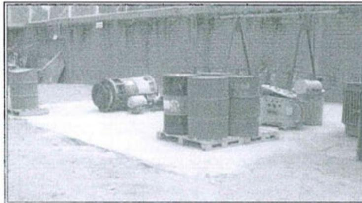
Vistas 8 y 9. Se observa en la parte posterior de la Casa de Máquinas de la CT Huápalas, el almacén de materiales que tiene en su interior transformadores en desuso conteniendo aceite residual y cilindros metálicos con aceite que no cuentan con un sistema de contención en caso de derrame que pueda evitar un impacto negativo al ambiente.
