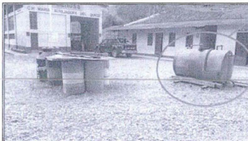
Vistas 2 y 3. Se observa dentro de la Casa de Máquinas de la CH Quiroz, el almacenamiento de combustible en cilindros metálicos y tanque rotoplast de polietileno junto con un tanque metálico con combustible que no cuentan con sistemas de contención en caso de derrame de HC que evite un impacto negativo al ambiente.
