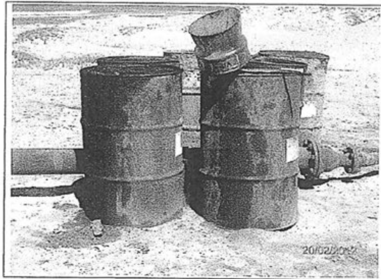
Fotografía N° 2: Litoral 3-4, pozo inyector L3-7, vista de cilindros en donde se almacena lubricantes dispuesto en un área sin impermeabilizar y sin el sistema de contención de derrame. Obsérvese suelos afectados con hidrocarburos.
