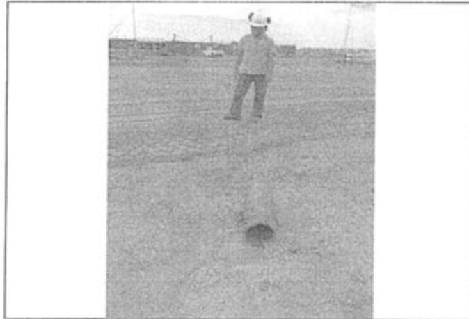
Fotografía N° 95: Bateria Panamá, vista de la tubería de seis pulgadas enterradas, que de acuerdo a lo indicado por la empresa no tiene ningún uso.
