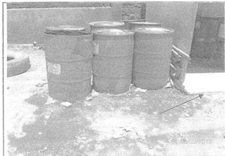
Fotografía N° 18: Vista de cilindros con productos químicos y lubricantes dispuestos a la intemperie, en un área sin impermeabilizar y sin un sistema de doble contención Asimismo, obsérvese suelos afectados con hidrocarburos.
