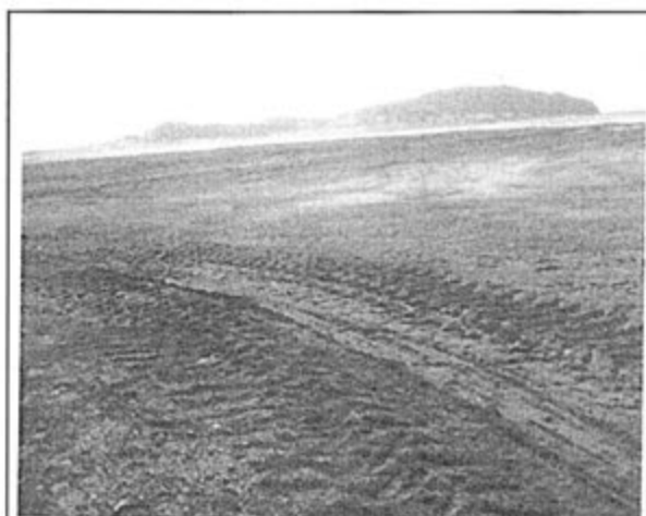
Bateria PTS UTM WGS E464553 N9483525: se limpió el área
