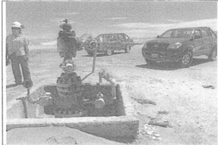
Fotografía N° 4: Vista del Pozo L3-13, obsérvese trapos, huaypes impregnados con hidrocarburos dispersos en el área.
