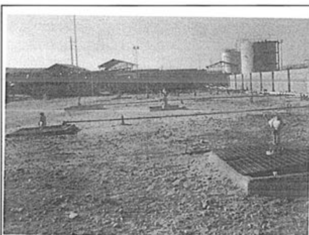
Pozo L1-10 (coordenadas UTM WGS84 E469270 N9496010): Se limpió el área
