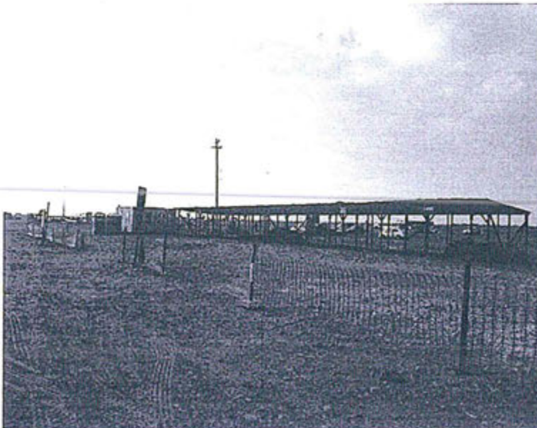
Fotografía N° 2: Vista panorámica del almacén temporal de residuos acondicionados
