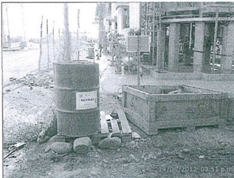
Fotografía N° 2: Residuos peligrosos junto a residuos no peligrosos y residuos orgánicos en recipiente de madera sin rótulo de identificación
