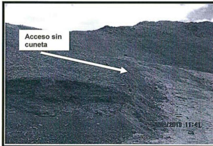
Fotografía N° 30 del Informe de Supervisión: "Accesos para el proyecto de las plataformas Tocracancha, ubicados entre las coordenadas WGS 84 E 0807429, N 8295568, efectuada con el menor corte del terreno posible, con un ancho aproximado de cuatro metros, no tiene cunetas, hecha en suelo natural. Los accesos en el área del proyecto también han considerado utilizar los accesos antiguos."
