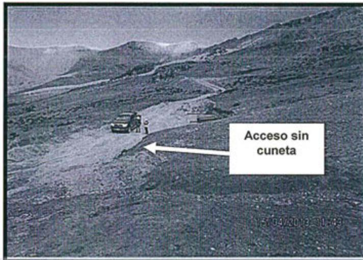
Fotografía N° 31 del Informe de Supervisión: "Accesos para el proyecto de las plataformas Tocracancha, ubicados entre las coordenadas WGS 84 E 0807429, N 8295568, efectuada con el menor corte del terreno posible, con un ancho aproximado de cuatro metros, no tiene cunetas."
