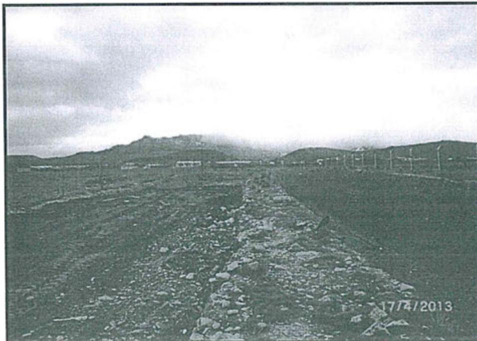
**Fotografía HZ N° 2.-**En la disposición final de residuos sólidos domésticos (Relleno Sanitario), se observó trinchera con el piso y paredes aún sin impermeabilizar, faltando sistemas de captación de lixiviados y chimeneas de gases.
