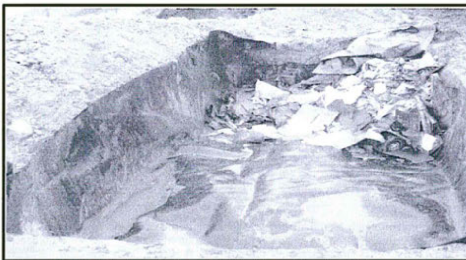
Fotografía N° 13: Trinchera de disposición final de residuos domésticos que no contaba con estructuras hidráulicas.
