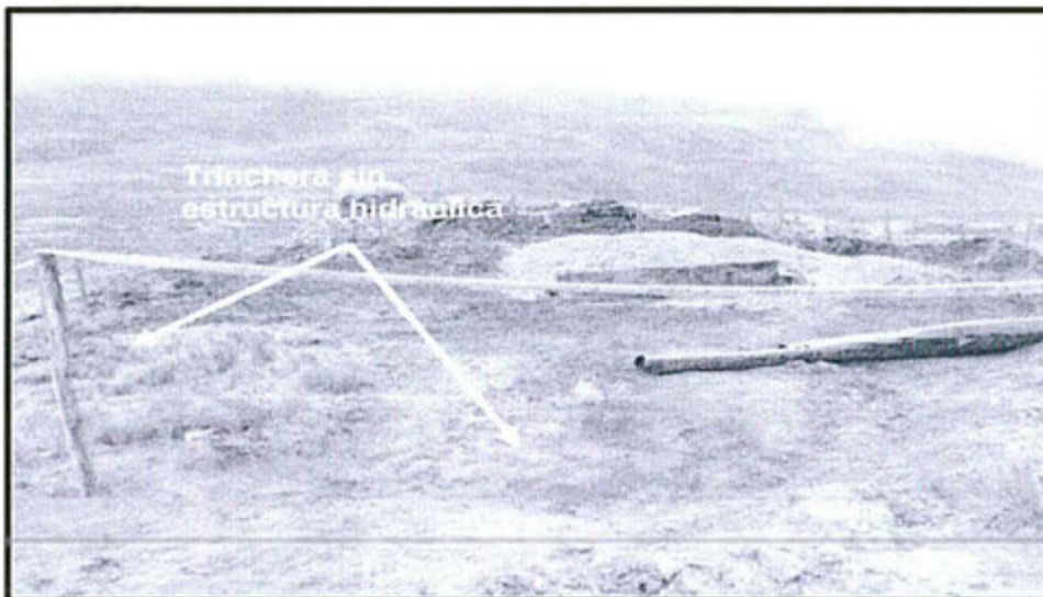
Fotografía N° 14: Trinchera de disposición final
