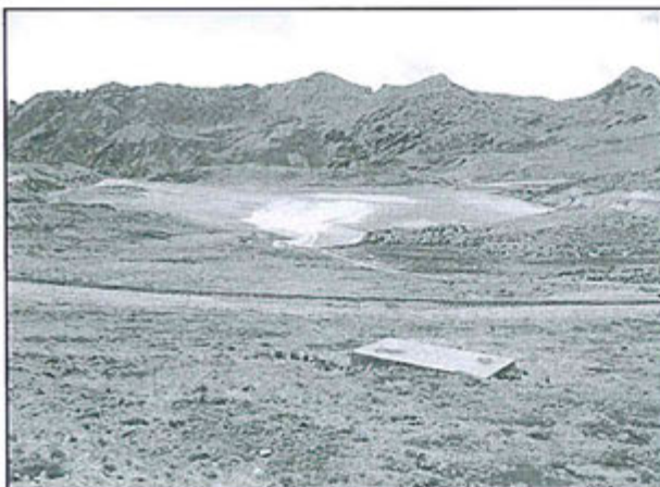
Foto 18: Observación 09, disposición de lodos en la relavera antigua, provenientes de la planta de tratamiento de aguas de mina San Nicolás.
