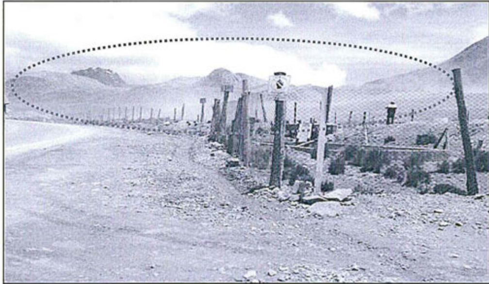
Foto 07: Observación 03, Generación de polvos por erosión eólica.
