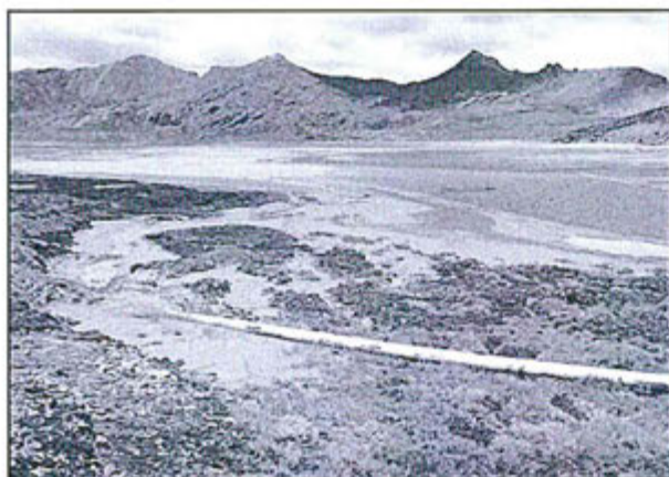
Foto 19: Observación 09, descarga de lodos en la relavera antigua, con inundación de agua, que compromete la estabilidad física y química.
