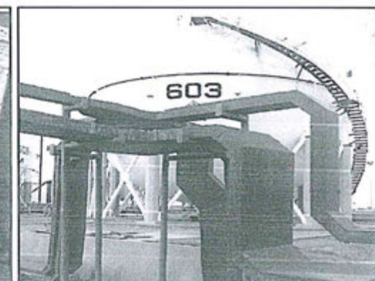
Fotografía N° 6 Escuadra ubicada en perímetro de Esfera N° 603 limpia
