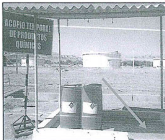
Fotografía N° 6 Zona de almacenamiento temporal de la Unidad de Vacío con doble contención, limpia, ordenada, envase rotulado y con señalización respectiva. Coordenadas UTM E: 0468544 y N:9493322
