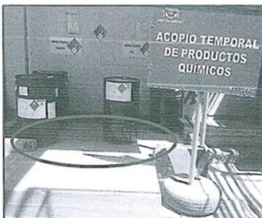
Fotografía N° 5 Zona de almacenamiento temporal de la unidad de craqueo catalítico con doble contención, limpia, ordenada, envases rotulados y señalización respectiva.
