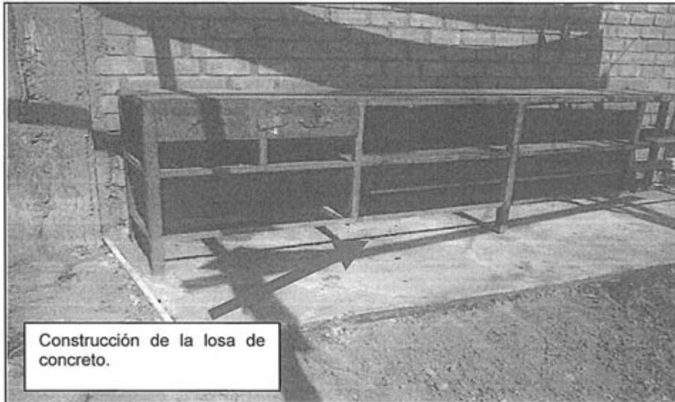
89. De la revisión de la fotografía se observa que en el área de mantenimiento de la Planta Envasadora de GLP – San Juan de Lurigancho, Flama Gas construyó una losa de cemento debidamente impermeabilizada. Asimismo, se observa la limpieza y retiro del filtro de petróleo y repuestos usados observados sobre el suelo natural durante la visita de supervisión.
