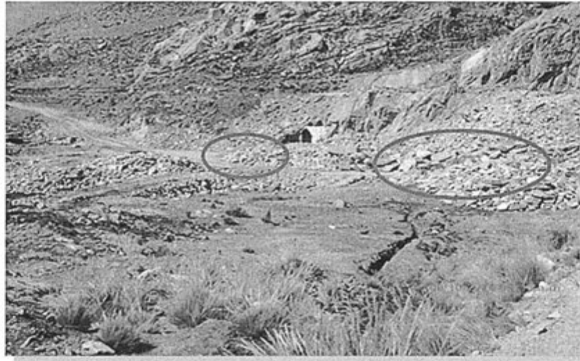
Foto 18: Observación N° 1, vista del túnel Victoria Nv. 380, donde se observa el desmorte extraído y depositado en el área superficial no autorizada.
