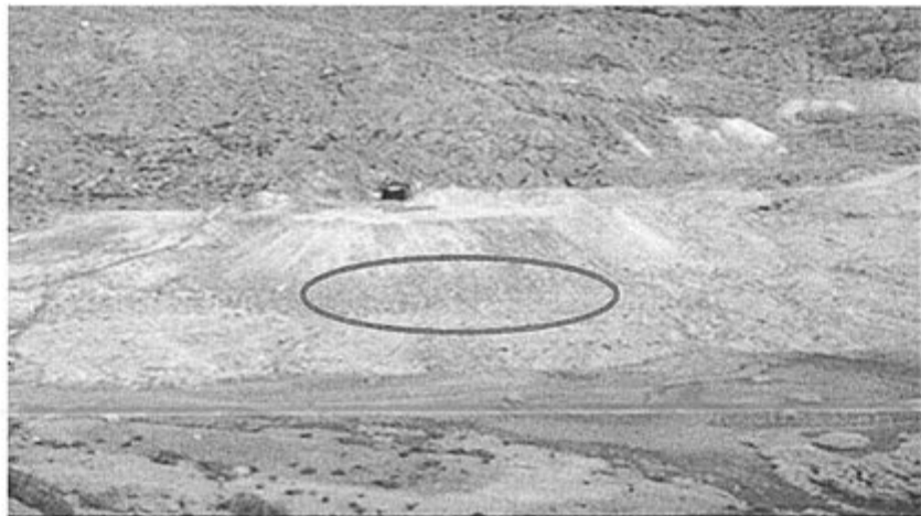
Foto 20: Observación N° 1, vista del túnel Victoria Nv. 330, donde se observa el desmorte extraído y depositado en el área superficial.
