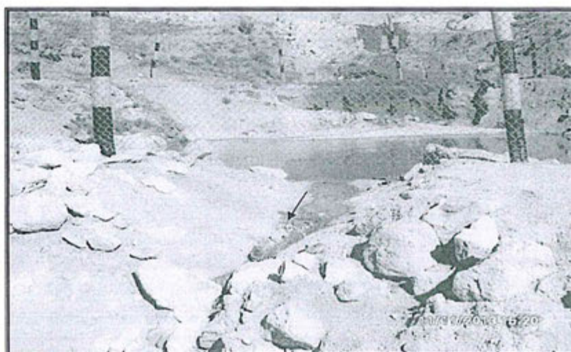
Fotografía 116: Hallazgo 5 – Punto de descarga del efluente de la Poza 2 hacia la Qda. Trapiche
