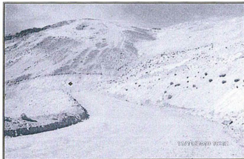
Fotografía 105: Hallazgo 3 – Carretera Pallancata – Iscahuaca y Depósito de Desmontes 1; no existe un sistema para captar a las aguas de contacto
