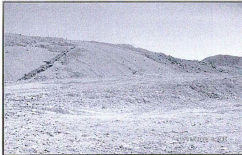
Fotografía 103: Hallazgo 3 – Depósito de Desmontes 1 no cuenta con canales de coronación para el desvío de aguas superficiales
