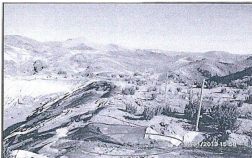
Fotografía 143: 6ta. Observación – NO LEVANTADA, persiste la rotura del geotextil, sedimentos en su interior y entorno, y falta de mantenimiento del canal de ingreso, de la Poza de Sedimentación del Depósito de Desmontes Pallancata
