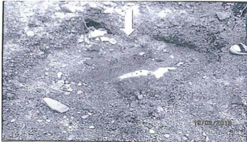
Fotografía N° 1.16.- No existe el tubo de obturación de la plataforma de exploración PL-7 (DHH-LY-07).
