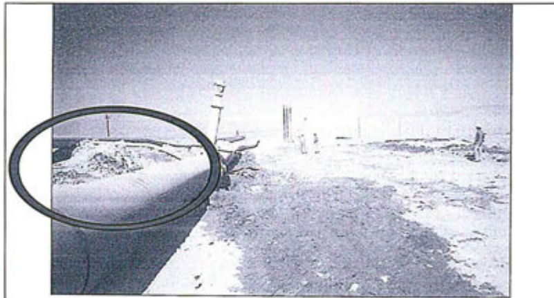
Vista N° 8.-Recomendación 2, derrame de relaves en área adyacente a tubería de conducción en Quebrada Honda
