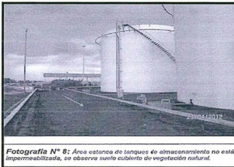
**Fotografía N° 8:** Área estanca de tanques de almacenamiento no está impermeabilizada, se observa suelo cubierto de vegetación natural.
