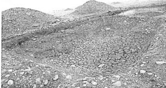
Fotografía N° 5. Poza de lodos (al centro) sin impermeabilizar, de la plataforma de exploración SG- 1070-2012.
