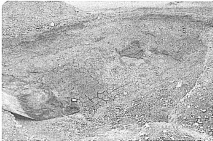
Fotografía N° 15. Tercera poza de lodos de la plataforma de perforación SG-1420-2012. La geomembrana se encuentra caída y en el fondo de la poza.
