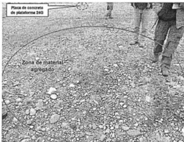
Fotografía N° 9. Presencia de material agregado a unos 8 a 10 m. de la base de la plataforma 24G. Coordenadas UTM WGS84, N: 8804438y E: 360455.
