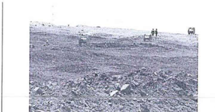
Vista Fotográfica N° 7: Nótese el material acumulado (tierra producto de la excavación) junto a las áreas donde se realizan las actividades de construcción de la L.T. 138kV
