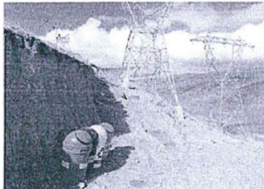
Evidencia N° 01: Instalación de Puntos de Acopio de Residuos
