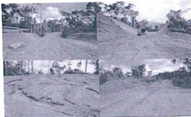
Fotografía N° 13: Vistas del derecho de vía
