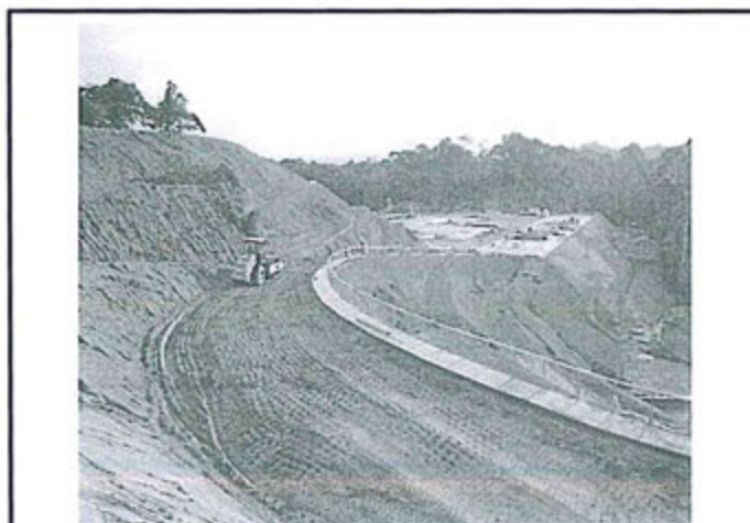
Foto N° 1.- Caminos de acceso y taludes, en pleno proceso constructivo, antes de los trabajos de revegetación en Plataforma Sagari.
