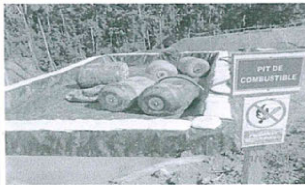
Fotografía N° 32: Inadecuado almacenamiento del combustible.
