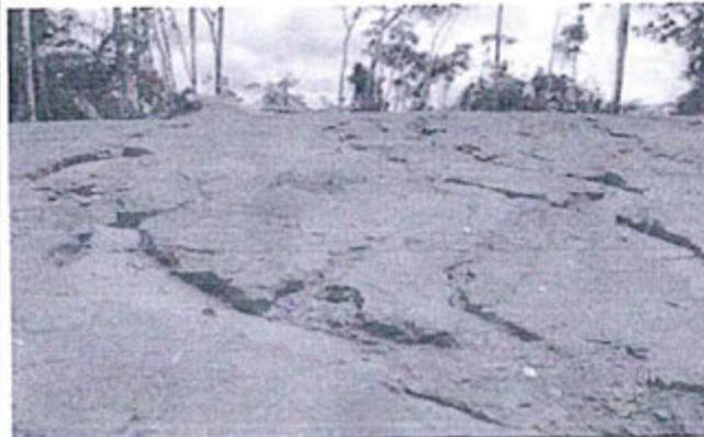
Fotografía N° 19: Inadecuado control de la erosión
