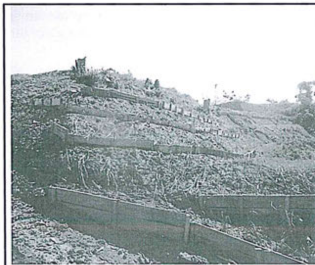
Foto N° 1.- Control de erosión para Top Soil con trincheras.
