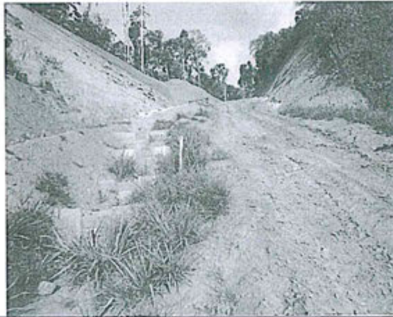
Foto N° 1.- Diques de sedimentación para control de erosión y trabajos de estabilización de taludes. Estos trabajos se repiten a lo largo del DdV.
