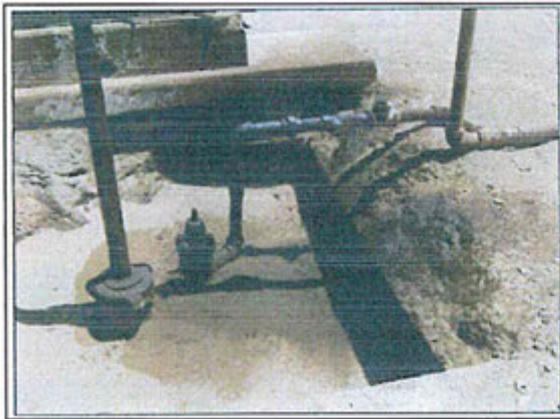
**Fotografía N° 14:** Se puede visualizar tierra impregnada con hidrocarburos (aproximadamente 1m<sup>2</sup>) sobre de suelo de la cantina del pozo 2476.
