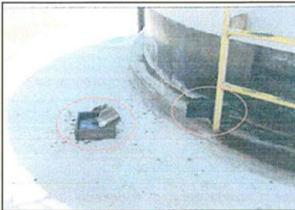
**Fotografía N° 2:** Se observan trapos y maderas impregnadas con hidrocarburos dispuestos sobre el área estancia de la Batería 814-Millon.
