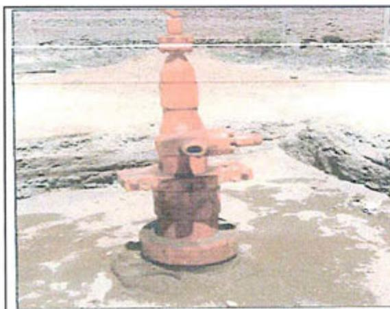
**Fotografía N° 17:** Se puede visualizar tierra impregnada con hidrocarburos (aproximadamente 1.0 m<sup>2</sup>) sobre el suelo de la cantina del pozo 1991.
