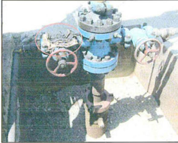
**Fotografía N° 1:** Se puede visualizar trapos impregnados con hidrocarburos sobre el cabeza del pozo 13273.
