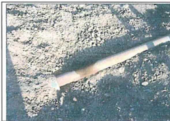
**Fotografía N° 30:** La tubería instalada a la salida de la bomba de la Estación de Bombeo 502 presenta una fuga de crudo en las coordenadas UTM E 0471714, N 9504448 (sistema WGS 84).
