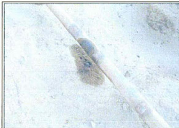
**Fotografía N° 28:** La tubería instalada a la salida de la bomba de la Estación de Bombeo 502 presenta una fuga de crudo en las coordenadas UTM E 0471714, N 9504441 (sistema WGS 84).
