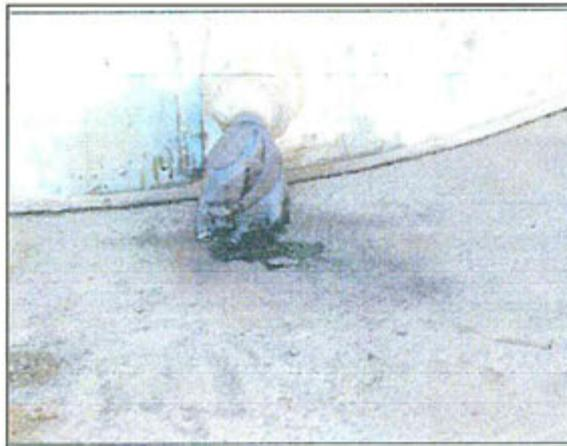
**Fotografía N° 27:** En el Centro de Acopio Folche, se detectó fuga de hidrocarburos por la brida del tanque.
