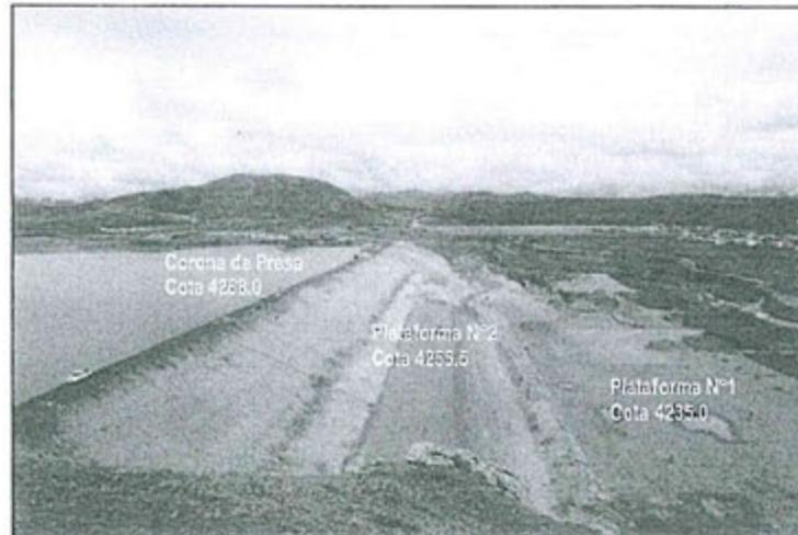
Foto 2: Vista General. Muestra la vista fotográfica AHORA (Enero 2015). Se aprecia la "nueva" configuración del cuerpo de presa Ocroyoc con sus dos plataformas hacia aguas abajo que conforman el espaldón de la presa. La "antigua" estación de bombeo de agua de recirculación ha sido desmontada y demolida las estructuras de concreto.
