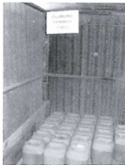
Foto N° 02.- Rótulos en el almacén de materiales peligrosos
