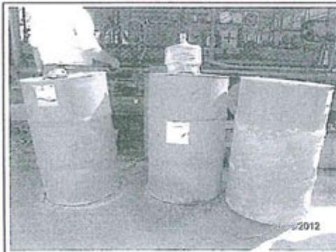
Fotografía N° 32: Vista de cilindros que almacena lubricantes dispuesto en un área sin impermeabilizar y sin sistema de contención de derrames (coordenadas UTM en WGS 84: 0530768, 9023887N).
