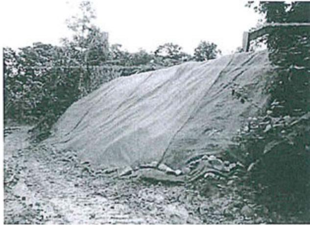
Pozo AC-8: Trabajos de remediación y compactación de suelo erosionado por efecto de lluvias
