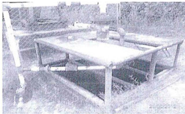
Fotografía N° 20: vista del Pozo inyector AC-20 (Coordenadas UTM – Sistema WGS 84: 0530565E, 9023606N). En dicho lugar se observó trazas de hidrocarburos en las aguas almacenadas en la cantina, en el cabezal del pozo paredes de la cantina y suelos circundantes de la cantina.
