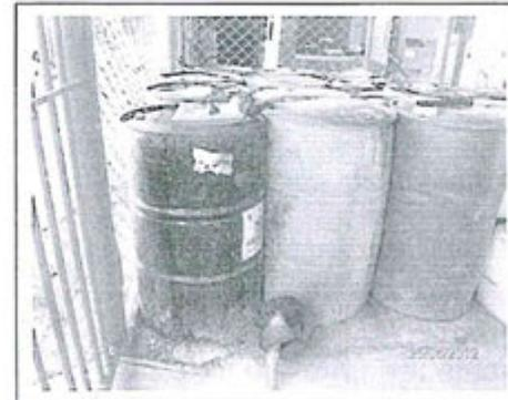
Fotografía N° 33: Vista de centro de almacenamiento de lubricantes y productos químicos en áreas inadecuadamente impermeabilizados y sin sistemas de doble contención (coordenadas UTM en WGS 84: 0530496E, 9023638N)
