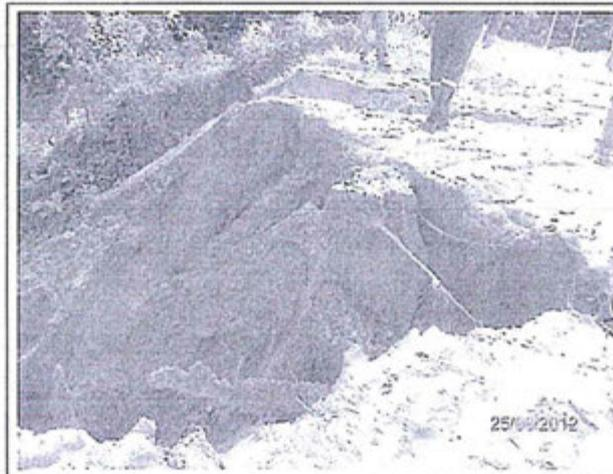
*Fotografía N° 38: Vista de la plataforma del pozo AC 8, colapsada y erosionada por efecto de las lluvias (coordenadas UTM en WGS 84: 0530409E, 9023260N).*
