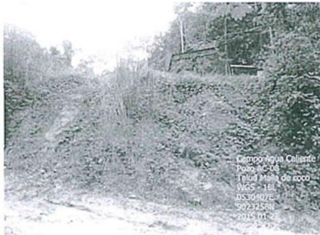
Pozo AC-8: Toma final de instalación de malla tipo coco y sembrío de vegetación para evitar erosión del suelo
