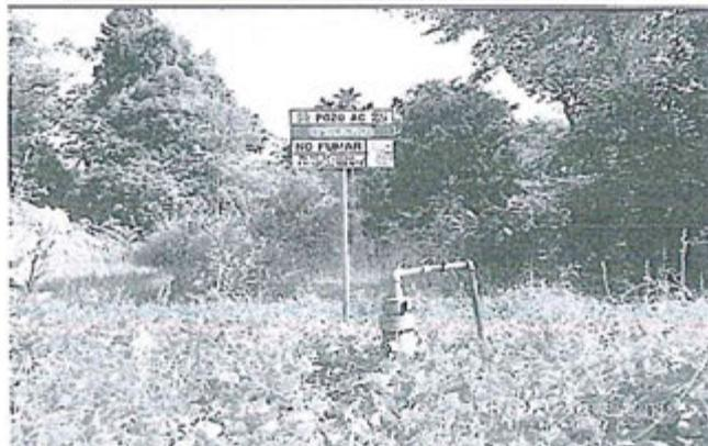
**Fotografía N° 18:** vista del Pozo inyector AC-25 (Coordenadas UTM – Sistema WGS 84: 0531135E, 9023783N) en dicho lugar se observó que el pozo inyector no tiene medidor de flujo.
