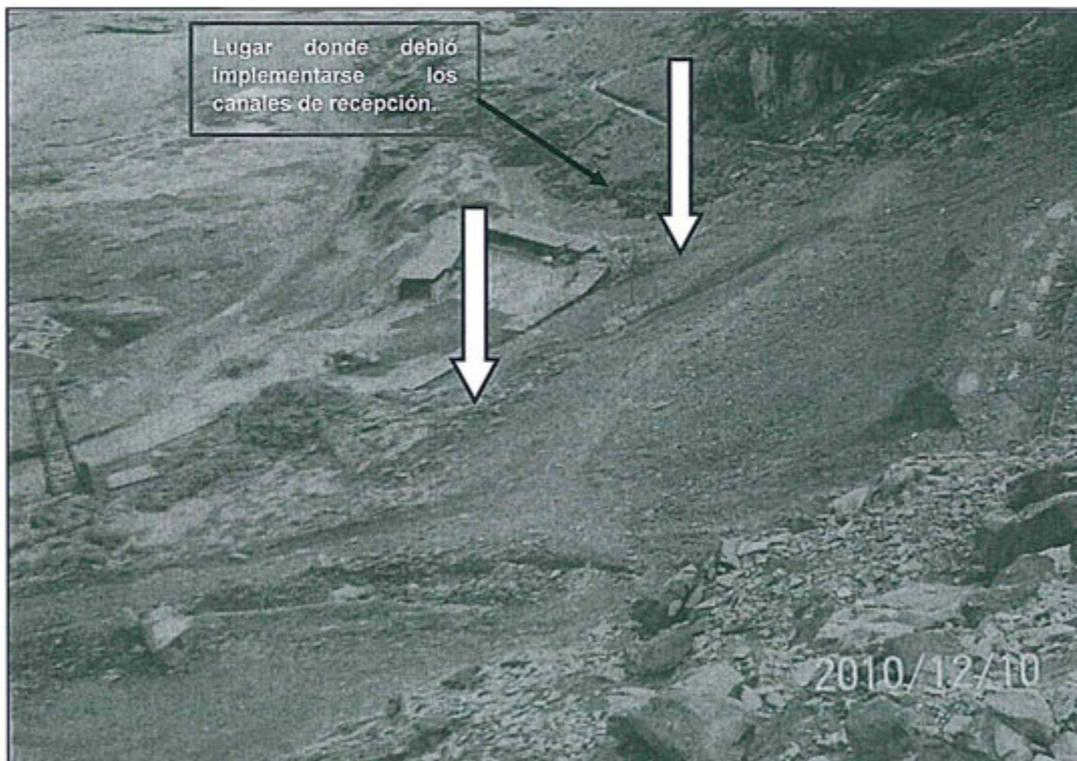
**Fotografía N° 13 del Informe de Supervisión.-** Durante la supervisión, se observó que no se había implementado canales de recepción para el drenaje de aguas que toman contacto con el material depositado en el botadero E-1 y E-23.
