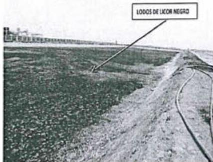
Foto N° 13. Laguna de confinamiento no impermeabilizada, en la cual se observa lodos de licor negro.
