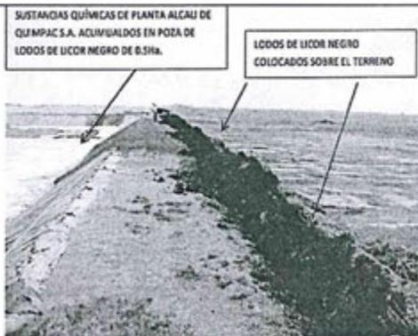
Foto N° 14. Remoción y acumulación de lodos de licor negro, provenientes de las lagunas de confinamiento de 1.5 y 0.5 Ha., sin impermeabilización. Además se observa uso de la poza para acumulación de sustancias químicas de Planta de álcali de Químpac S.A.
