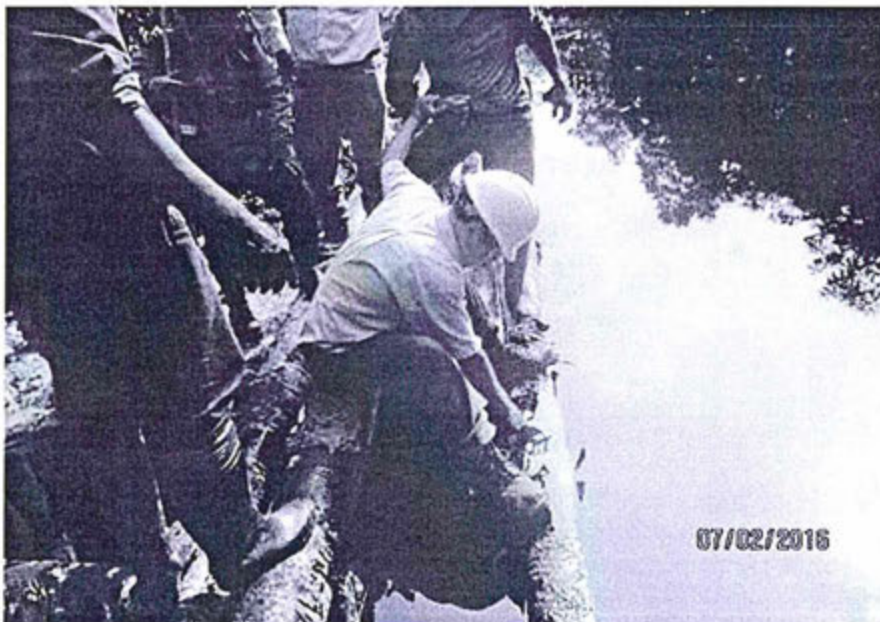
Foto 20: Muestra el área afectada en el punto donde se produjo el derrame de petróleo crudo por falla en el oleoducto. Coordenada WG84: 9524314N/0237150E.
