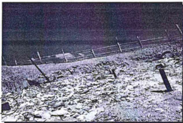
Foto 41: Vista del relleno sanitario sin impermeabilización, utilizado para disponer residuos sólidos domésticos, industriales y peligrosos.
