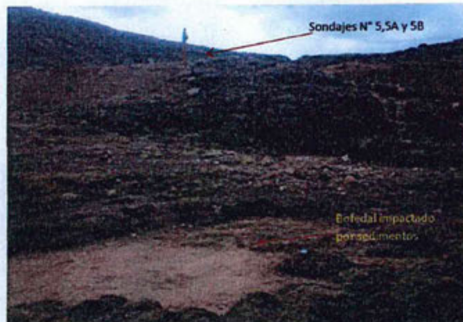
Fotografía N° 7: Se observa el bofedal aguas abajo de los sondajes N° 5, 5A y 5B, ubicado en E 770014 – N 8387220, la plataforma no cuenta con sistema hidráulico para evitar arrastres de sedimento al bofedal ubicado a menos de 12 m aprox.
