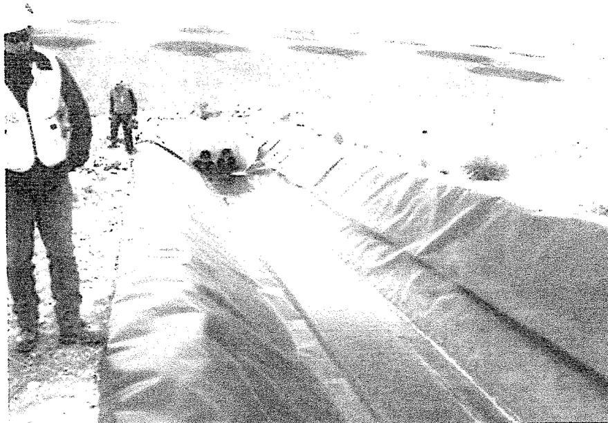
Fig. 7 Dren del canal basal al pie de la relavera Huinipampa, lado Este del canal colector, antes de su ingreso a la poza de contingencia Huinipampa
