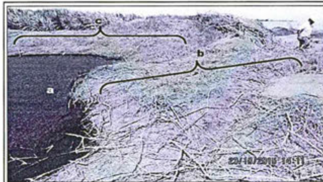
Foto N° 39: Se observa un sector de la poza de evaporación y sedimentación N° 1 (a), el dique de contención cubierto por restos de maleza (b), cercano a los campos de cultivo de caña de azúcar Trupal N° 1 (c).
