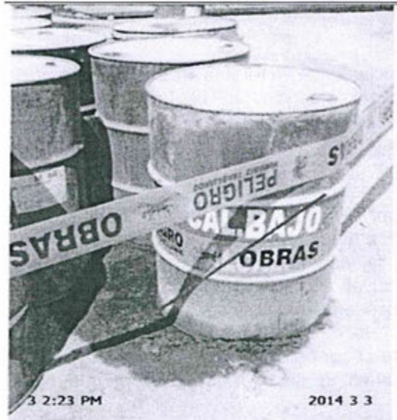
Foto N° 68: Se aprecia impregnación de sustancias derivado de hidrocarburos sobre suelo afirmado, zona donde se almacena cilindros metálicos en desuso apilados a la intemperie y sin medio de contención. Coordenadas UTM WGS84 8652302N 292776E.
