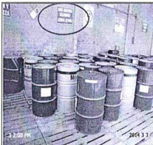
Foto N° 65: El punto de acopio para cilindros que contienen residuos peligrosos almacena más de la capacidad indicada en el letero del punto de almacenamiento, en el momento de la supervisión se contaba con 32 cilindros, siendo su capacidad (según letero) de 22 cilindros.
