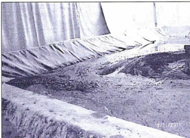
Foto N° 19. Capahuari Sur.- Pozo Capahuari 1802-H. Los recortes y lodos de perforación se encuentran en una poza con geomembrana y techada.
