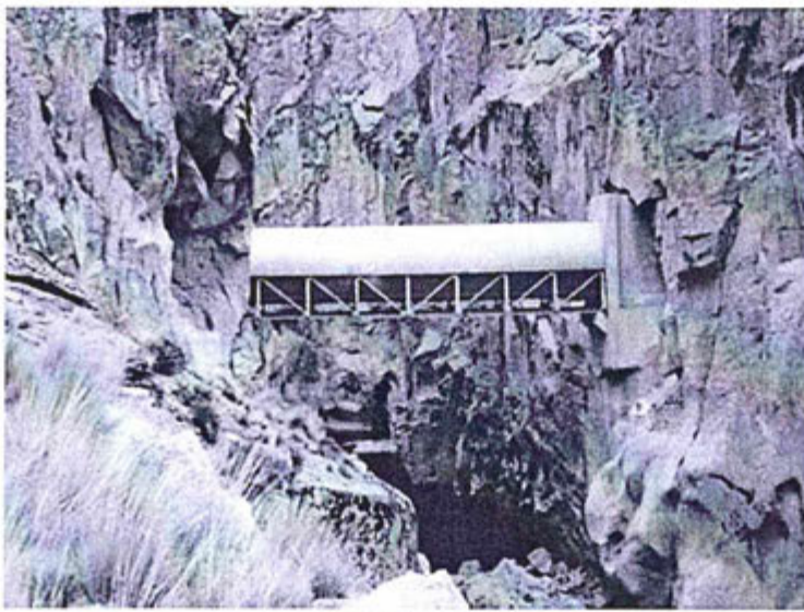
Fotografía 02: Puente tubo que uno los túneles en la roca por donde discurre el agua
