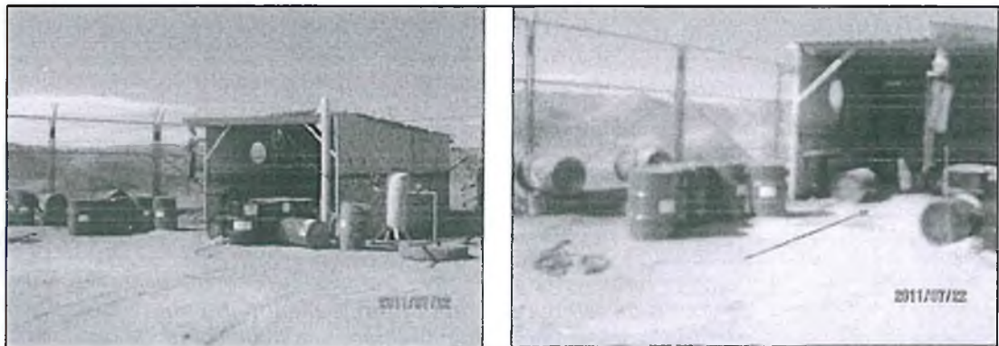
Fotografía N° 1: Vista panorámica de la caseta en donde almacenan los lubricantes en la Batería Primavera.
