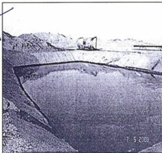
Foto 09: Vista de la fosa de cortes manchada con petróleo crudo
