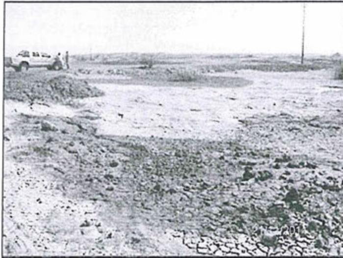
Fotografía N° 1: Vista de la poza de lodos N° 1, utilizadas en la sismica Mirador 3D 45
