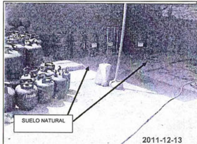
Fotografía N° 1: El Almacén Temporal de sustancias químicas de la Planta Envasadora de GLP, se observa el almacenamiento de Once (11) Cilindros de Pintura, en un área que no está impermeabilizada y no cuenta con sistema de doble contención, para evitar la contaminación del suelo natural.
