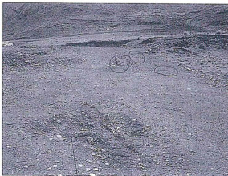
Brotos de vegetación en la zona donde se realizó la limpieza de sedimentos acumulados por el desborde del canal Marcapomacocha
