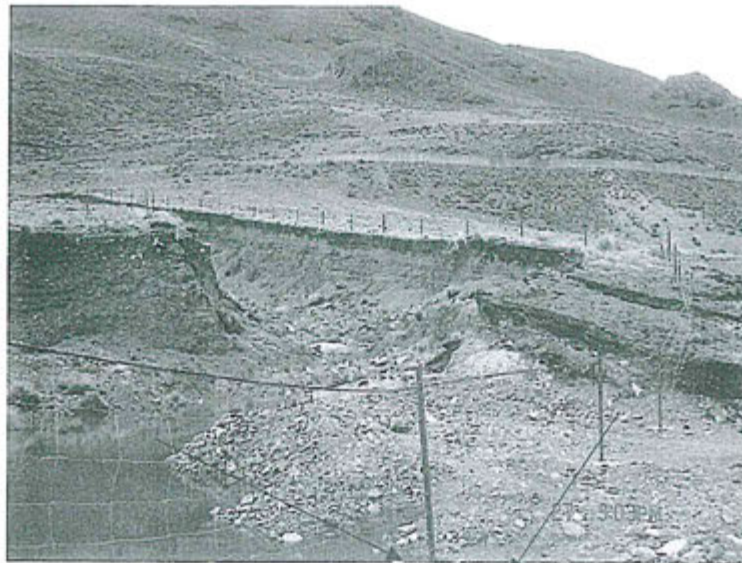
Cerco perimetral de malla con postes metálicos en la zona erosionada por el desborde del Canal Marcapomacocha, con la finalidad de evitar caída de personas y ganado
