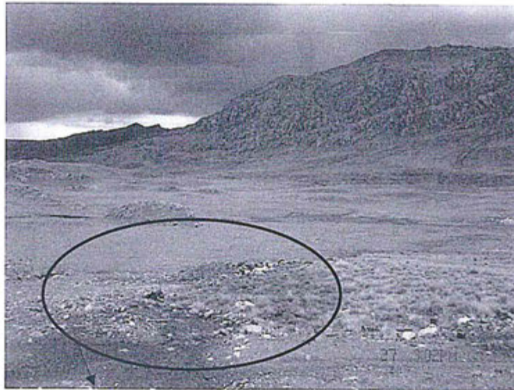
Limpieza de sedimentos acumulados en el pastizal por el desborde del Canal Marcapomacocha
