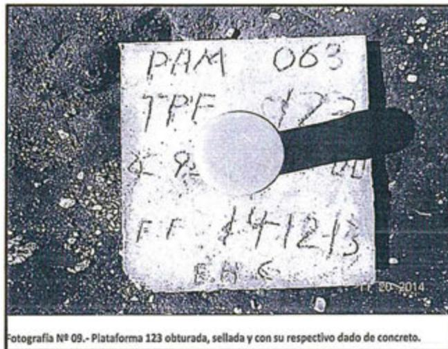
Fotografía N° 09.- Plataforma 123 obturada, sellada y con su respectivo dado de concreto.
