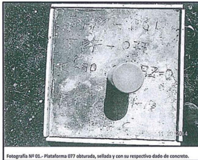
Fotografía N° 01.- Plataforma 077 obturada, sellada y con su respectivo dado de concreto.
