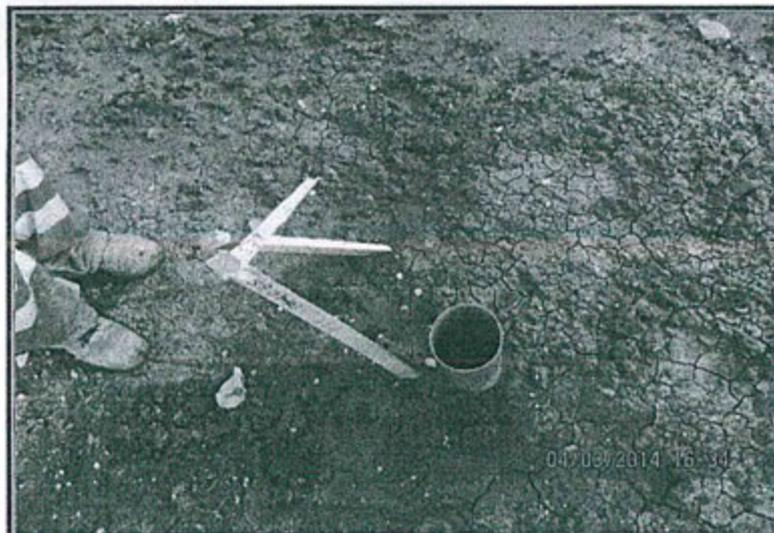
Fotografía N° 85: Plataforma PTF - 085 se encuentra obturada, pero no cuenta con su dado de concreto armado.
