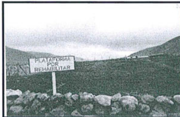
Fotografía N° 2: Plataforma 32 en proceso de rehabilitación
