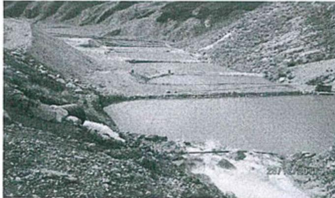
Fotografía N° 119. En la visita de inspección realizada a las plantas de tratamiento de aguas de mina (nivel 240 y nivel 0) se ha observado que éstas han sido construidas sobre terreno natural.
