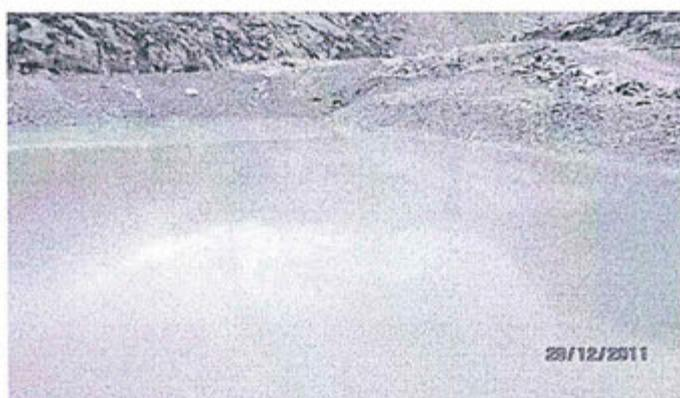
Fotografía N° 94. Poza de floculación de sólidos en suspensión de la planta de tratamiento del nivel 240. Se observa que ha sido construida sobre terreno natural.
