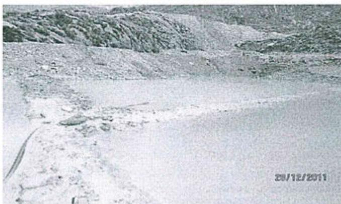
Fotografía N° 92. Poza de floculación de sólidos en suspensión de la planta de tratamiento del nivel 240. Se observa que ha sido construida sobre terreno natural.
