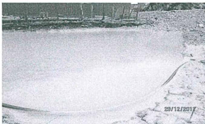
Fotografía N° 91. Poza de floculación de sólidos en suspensión de la planta de tratamiento del nivel 240. Se observa que ha sido construida sobre terreno natural.
