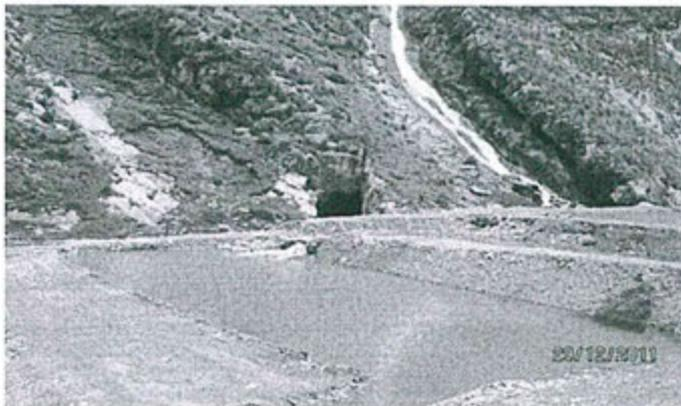
Fotografía N° 120. En la visita de inspección realizada a las plantas de tratamiento de aguas de mina (nivel 240 y nivel 0) se ha observado que éstas han sido construidas sobre terreno natural.
