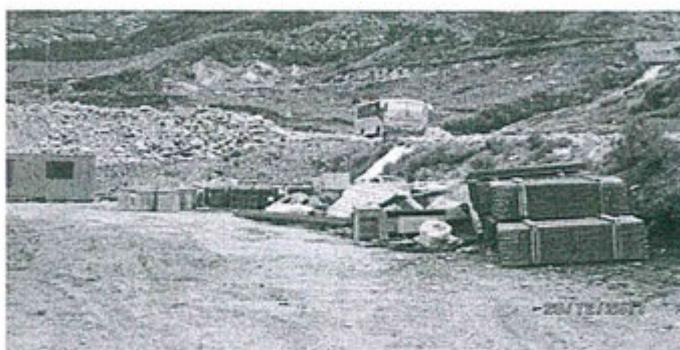
Fotografía N° 3. En el área de estacionamiento, nivel 0, existen cilindros de lubricante y de aditivo para concreto sellados sobre suelo natural, sin poza para la contención en caso de derrames.
