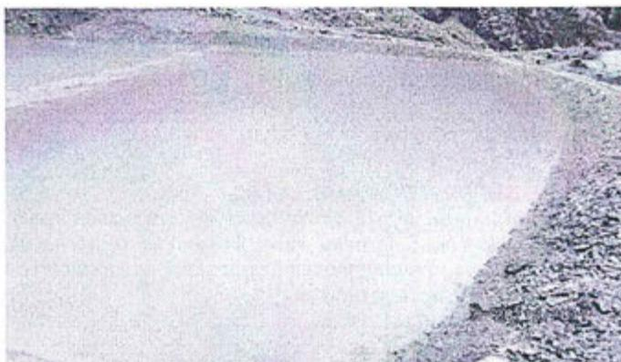
Fotografía N° 93. Poza de floculación de sólidos en suspensión de la planta de tratamiento del nivel 240. Se observa que ha sido construida sobre terreno natural.
