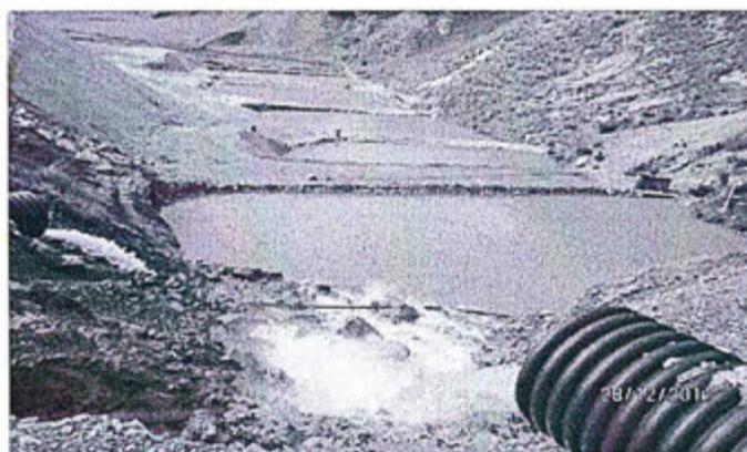
Fotografía N° 118. En la visita de inspección realizada a las plantas de tratamiento de aguas de mina (nivel 240 y nivel 0) se ha observado que éstas han sido construidas sobre terreno natural.
