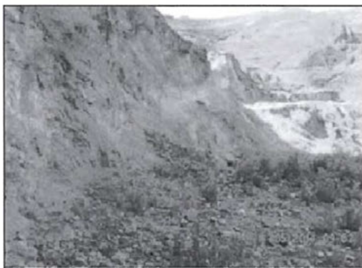
Fotografía N° 23: El flanco sur del relleno sanitario Santa Bárbara no cuenta con un sistema de impermeabilización.
