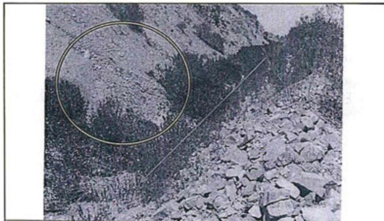
Fotografía N° 76.- HALLAZGO 01: Canal de coronación del tajo abierto, con presencia de vegetación arbustiva y deslizamiento de talud (ver línea y círculo rojo) en varios tramos de su trayecto, entre las coordenadas UTM N-8095159; E-330773 y N-8095015; E- 330724
