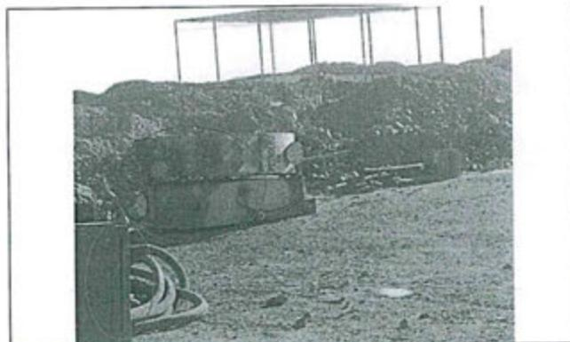
Fotografía N° 100.- HALLAZGO 10: Disposición de tanques impregnados con combustibles directamente en el suelo, cajones de madera y otros materiales.
