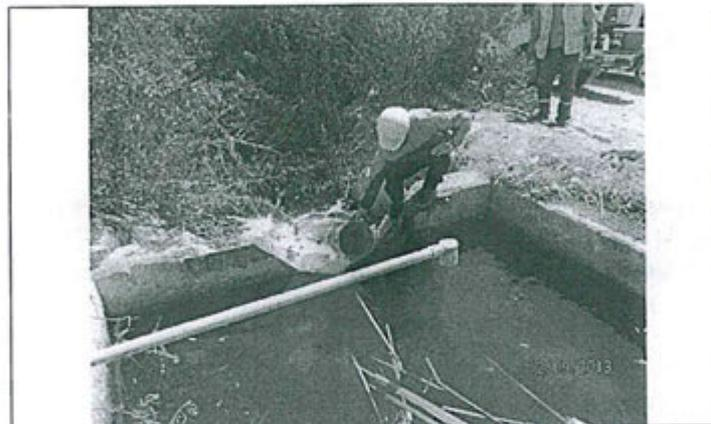
Fotografía N° 107.- Muestra de Efluente Industrial Punto de monitoreo PD-PR tomada en el vertedero con coordenadas UTM E 306533 N 8064993. Vista del personal de laboratorio en proceso de la toma de muestras agua en vertimiento de la poza de sedimentación A de las aguas que filtran del embalse de relaves.
