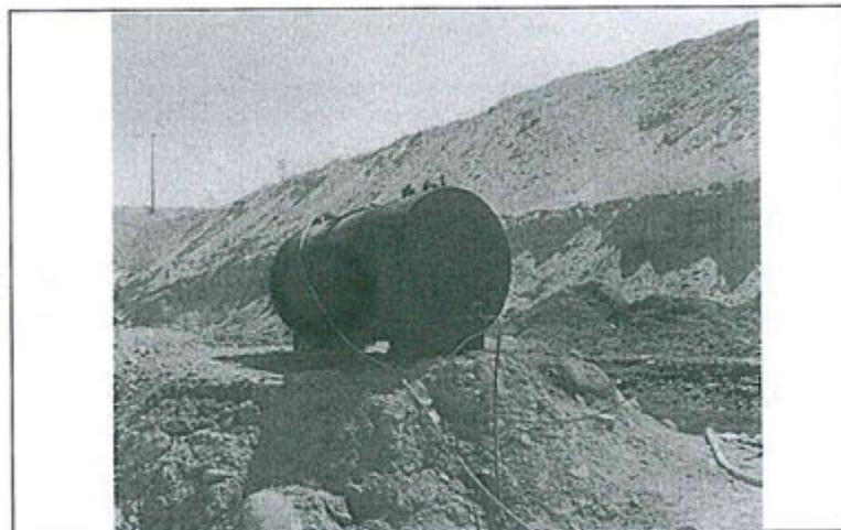
Fotografía N° 80.- HALLAZGO N° 02: Tanque de combustible sin bandeja de contención en caso de derrames, se observa suelo afectado con dicha sustancia peligrosa (círculo rojo).
