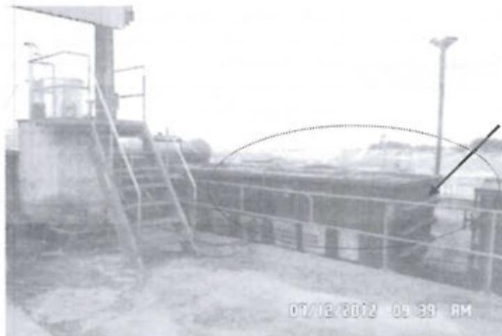
Fotografía N° 78.- Supervisión Regular 2012, Observación N° 7, área de carguío de concentrados de la planta concentradora, se observa acumulación de concentrados en los rieles de la vía férrea e impregnaciones en las paredes laterales de los vagones.
