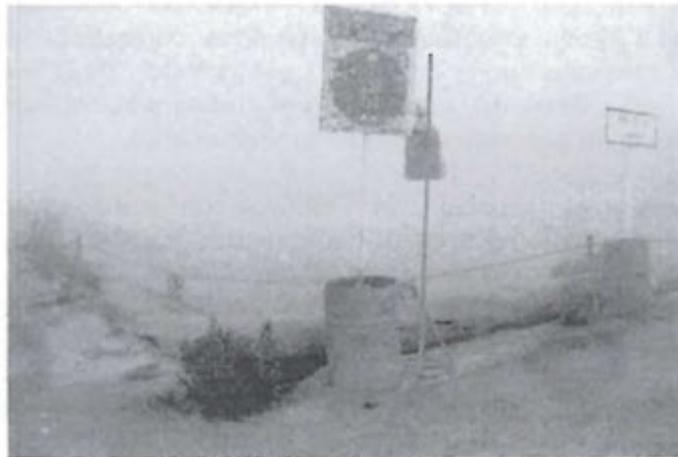
Fotografía N° 74.- Supervisión Regular 2012, Observación N° 5, Poza de PLS del PAD de Lixiviación Cuajone, no cuenta con una barrera de protección que impida el ingreso de animales pedestres.
